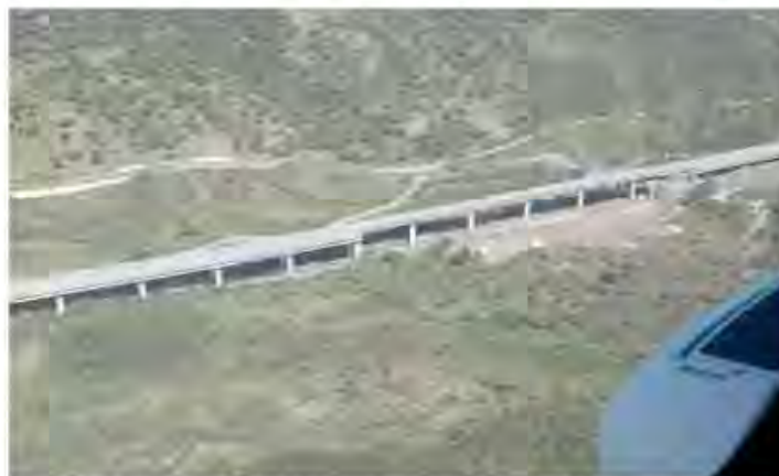
IL VIADOTTO HIMERA SULL'A19 PALERMO-CATANIA VISTO DALL'ELICOTTERO SUL QUALE È ARRIVATO IL PREMIER MATTEO RENZI
